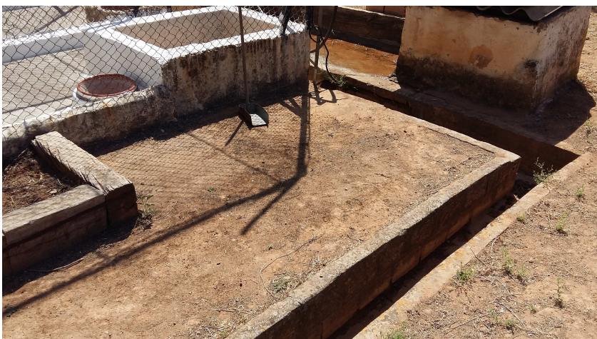
Acequia de conducción de aguas de pluviales para proteger las perreras del agua.
