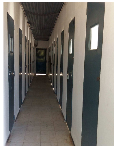
Pasillo central en perrera cerrada
