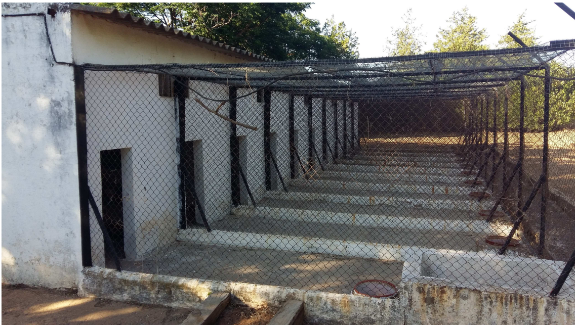
Patio de perrera cerrada (con cubierta de malla para evitar que los gatos se escapen)
