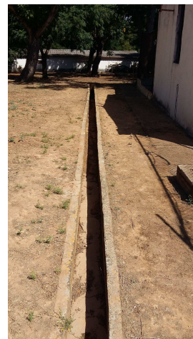
Acequia de conducción de aguas de pluviales para proteger las perreras del agua.
