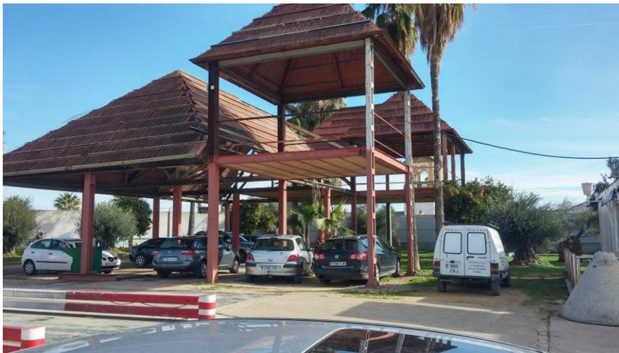
Fot. 7: construcción B1
