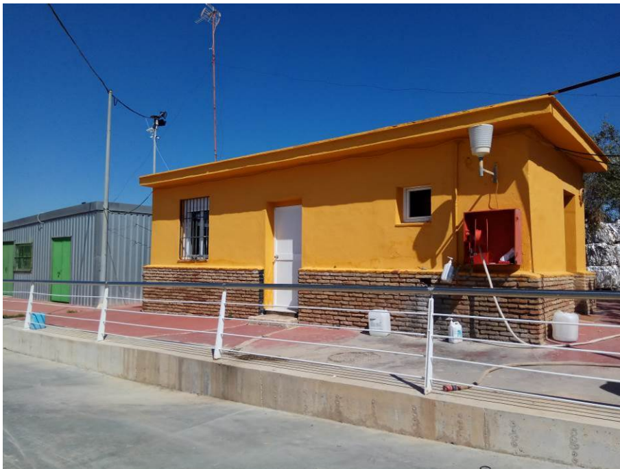
Fot. 5: Vista exterior de construcción A3
