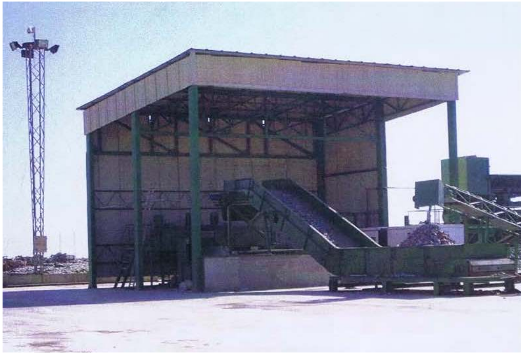
Fot. 12: Construcción B4
