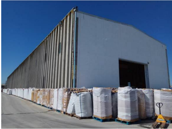
Fot. 1: Construcción A2 (zona Nave)
