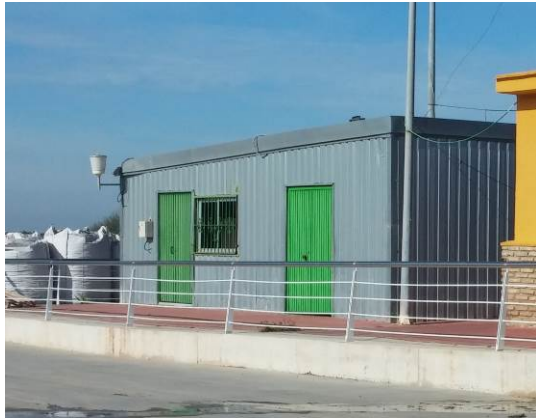
Fot. 8: Construcción B2 (vista exterior)
