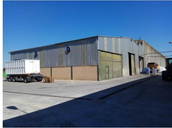
Fot. 2: Construcción A2 (zona Taller)
