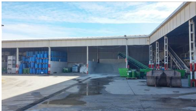
Fot. 15: Construcción B5
