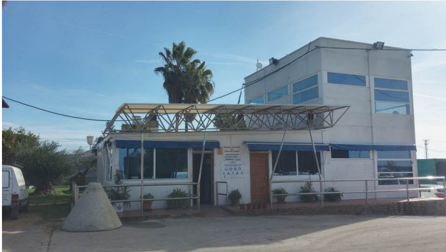
Fot. 4: Construcción A1 (Oficinas)
