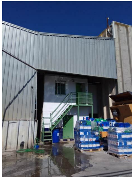
Fot. 3: Construcción A2 (zona Aseos)
