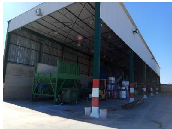
Fot. 10 y 11: Construcción B3
