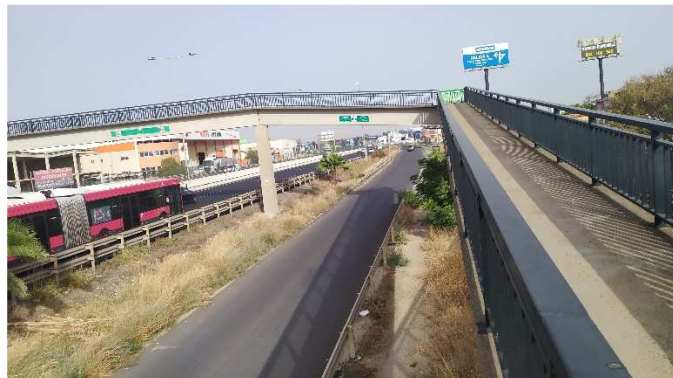
Vista vía de servicio desde pasarela.
