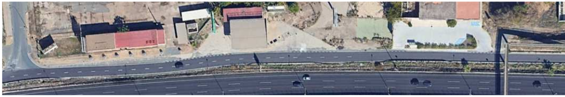
Vía de servicio con hasta zona EESS con una vía con un carril y a partir de la EESS doble carril.
