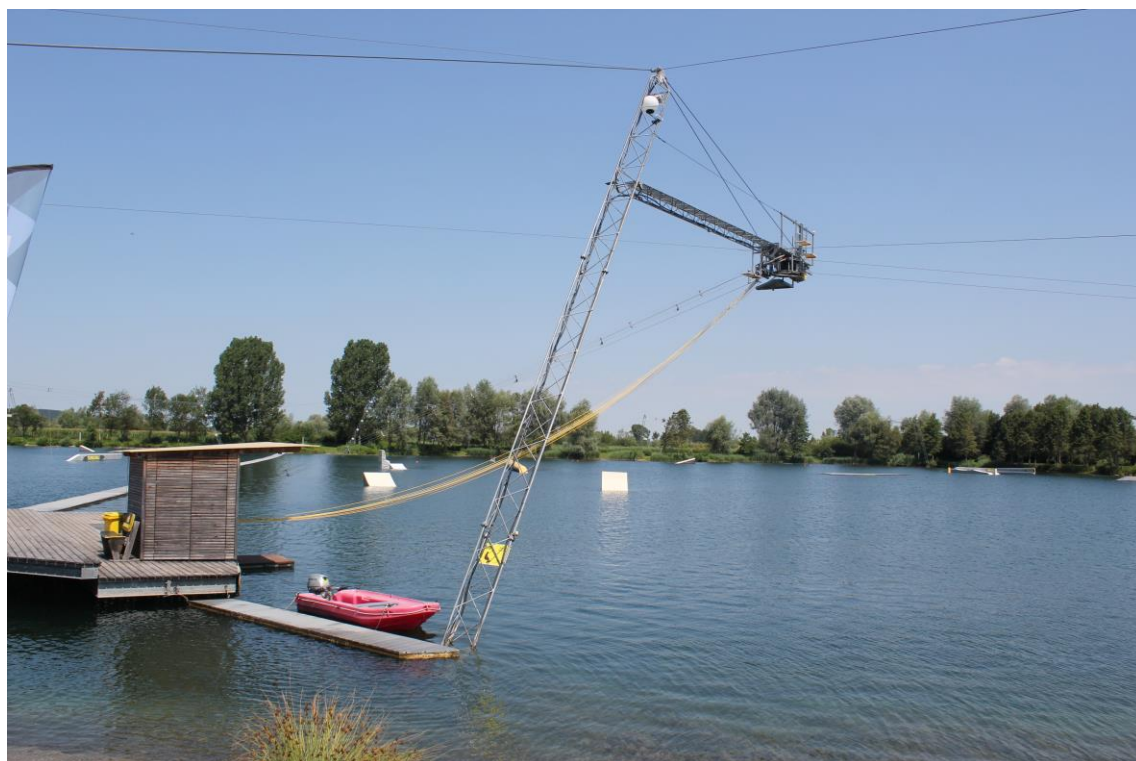
Detalle de la instalación de Cable Ski en Baviera (Alemania)
