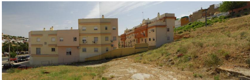
Vista lateral de edificaciones de la UE-36
