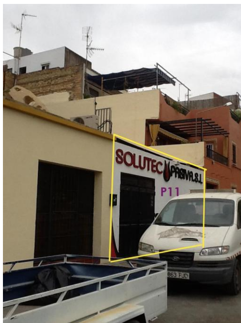
Construcción en parcela 11, desde calle de Cuba
