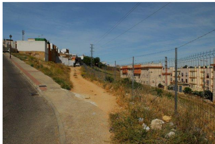
Vista desde confluencia Calle de Cuba y Calle de Méjico
