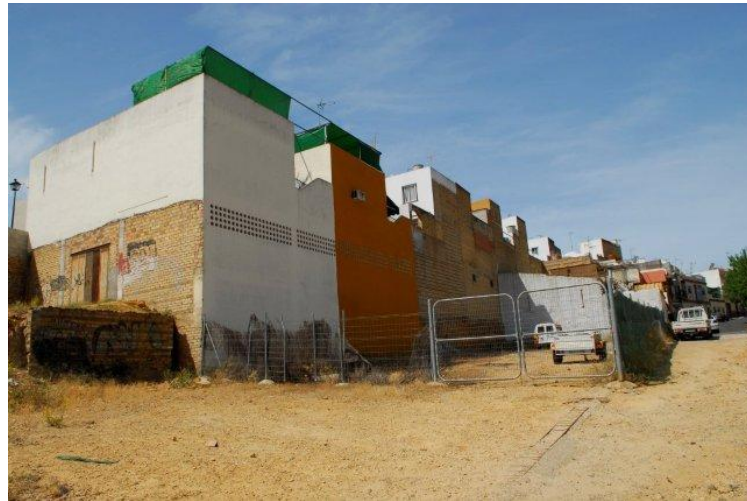
Construcciones en Parcelas 9, 10, 11 y 12
