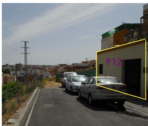
Construcción en parcela 12, desde calle de Cuba
