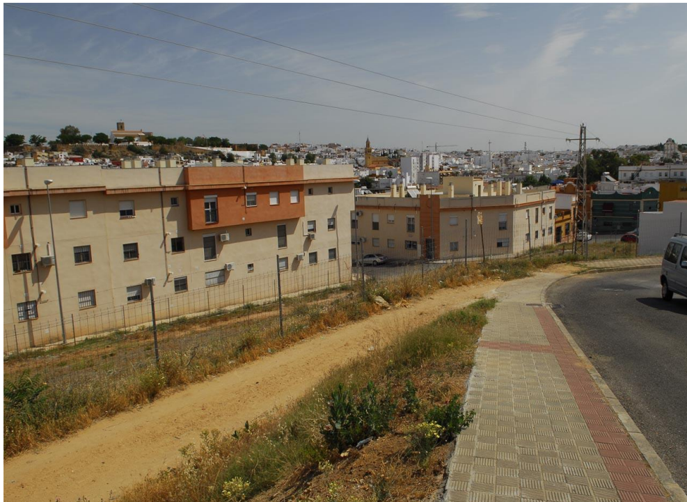
Vista del extremo Sudeste, UE-36 desde Calle de Méjico.
