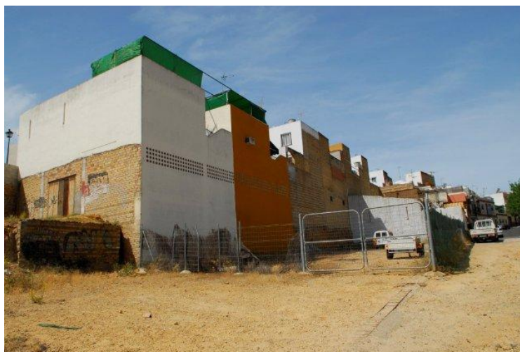
Construcciones en Parcelas 9, 10, 11 y 12
