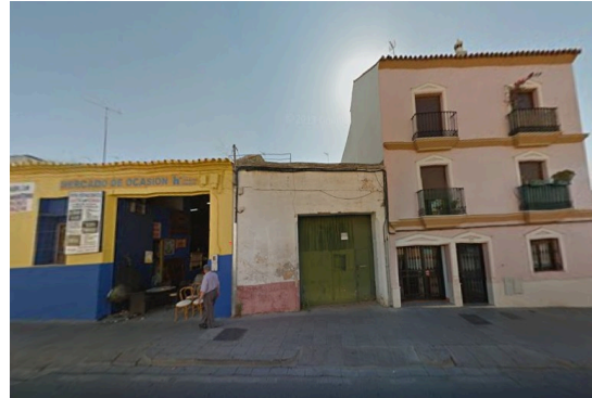
Vista del frente de la edificación desde C/ Arahál
