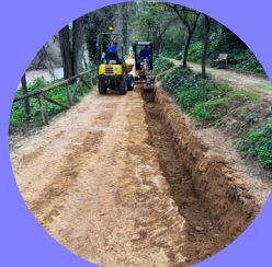
Obras para la iluminación del Camino de Oromana
